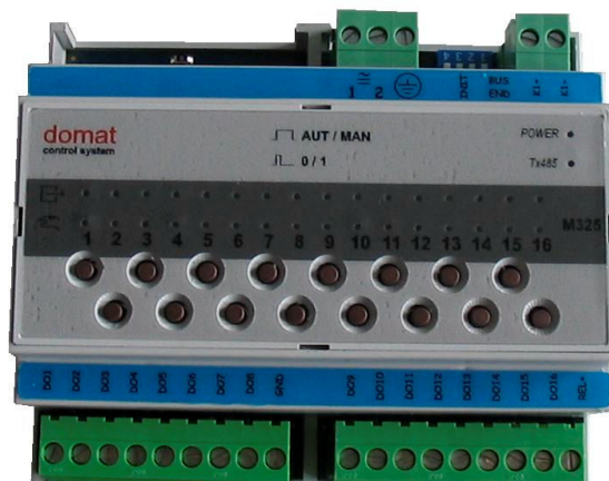
Modul M325 s tlačítky a LED pro manuální přeřízení
