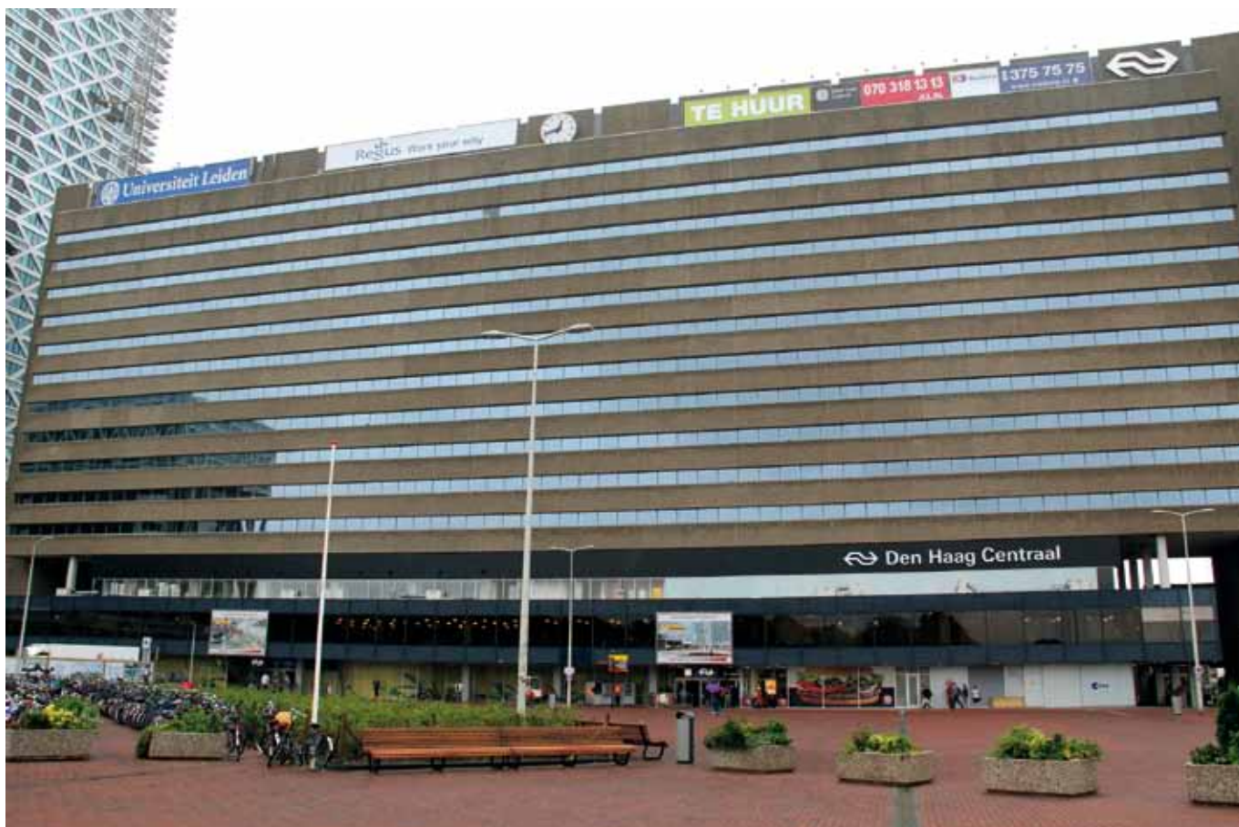
Obr. 1 Pohled na budovu ze severní strany
